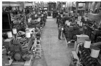
Die 40 Diesel-Gensets auf Basis von MTU-Motoren der Baureihe 4000 werden im MTU-Onsite-Energy-Werk in Mankato, Minnesota, montiert.
